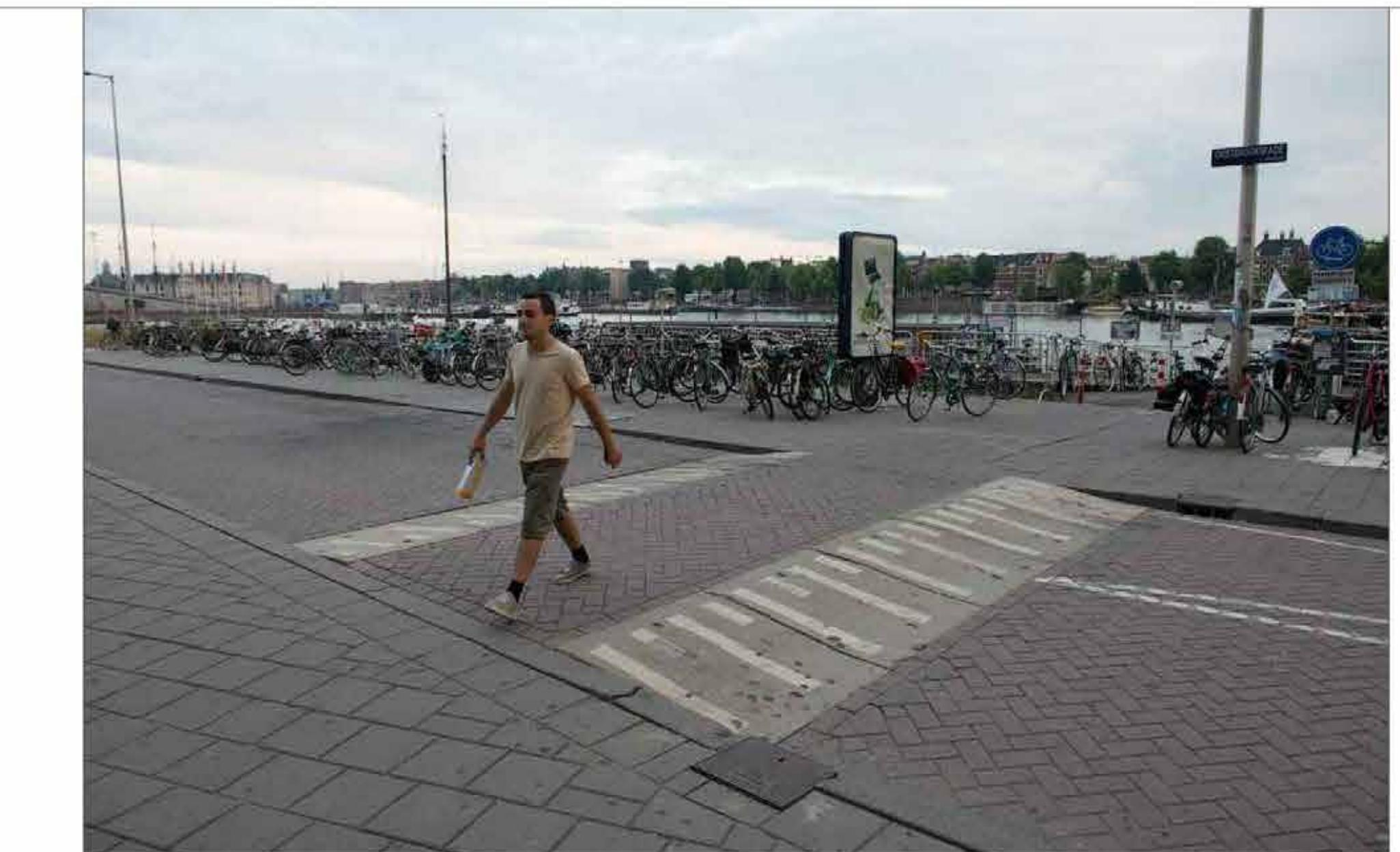
Пример устройства пересечения проезжей части велополосой
