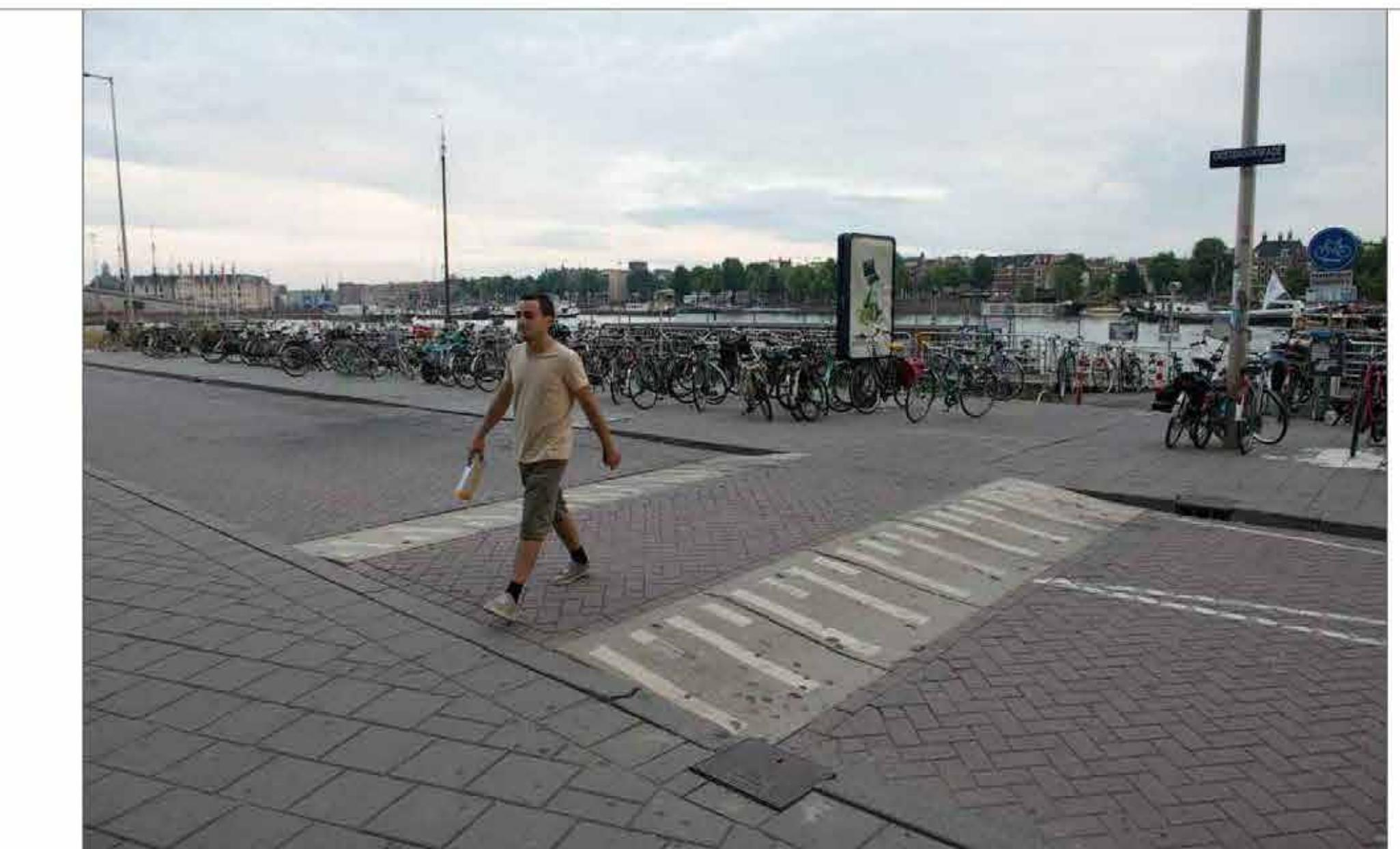
Пример устройства пересечения проезжей части велополосой зарубежный опыт
