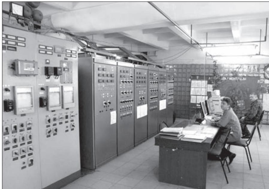
• Котельная №4 — одна из лучших в Одинцово. Она снабжает теплом 4-й и 5-й микрорайоны. В котельной установлено новое оборудование, а управление осуществляется операторами из пультовой с помощью компьютерной техники.
