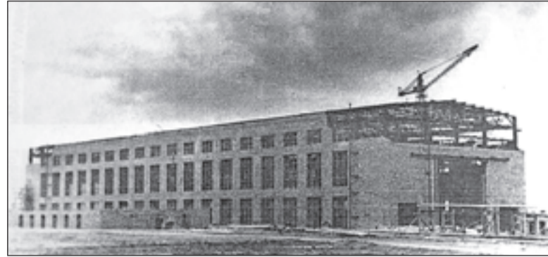
• 1956 год. Строительство МИК (монтажно-испытательного корпуса).
