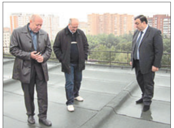
• Глава города А.А. Гусев (в центре) оценивает состояние крыши.
