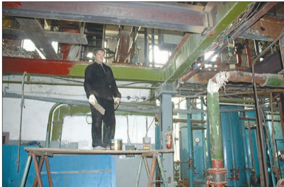
• В котельной готовятся к установке теплообменников.
